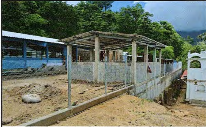
Foto 1: Terminación de muro de contención, cocina y circulación con postes de tubo y malla área frontal.
